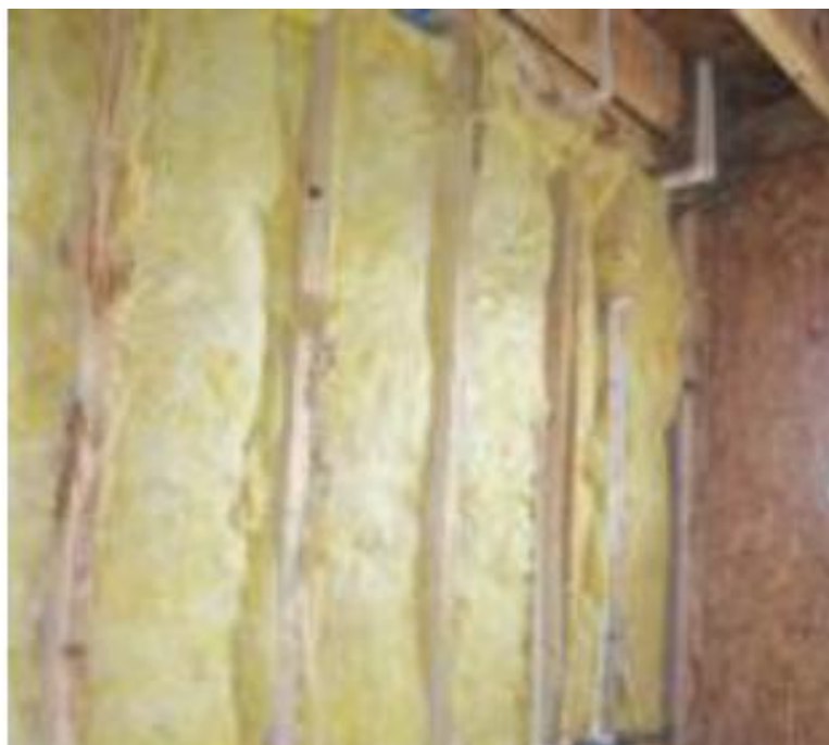
Figura 8: Isolamento Termoacústico Nos Painéis Fonte: Lp Building Products (2011).
