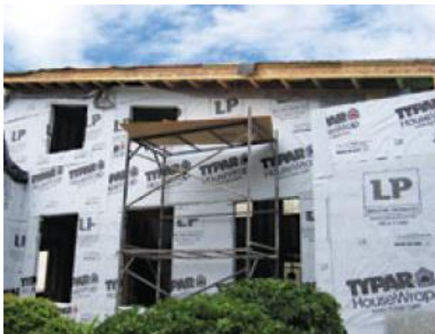
Figura 7: Membrana Hidrófuga Fonte: Lp Building Products (2011).
