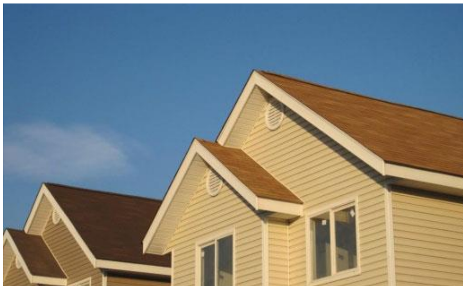
Figura 12: Revestimento Com Sidings Fonte: Tecverde (2012).
