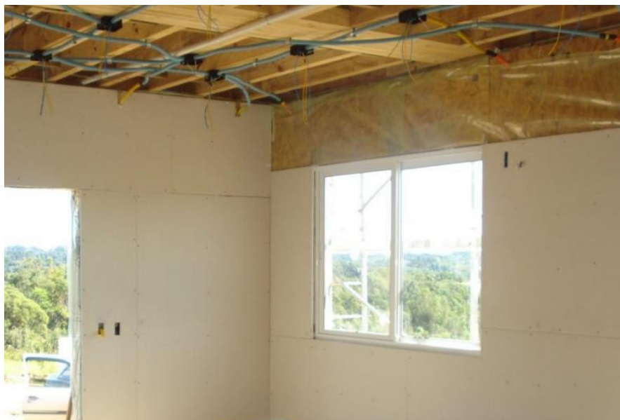
Figura 10: Instalação Elétrica Fonte: Tecverde (2012).
