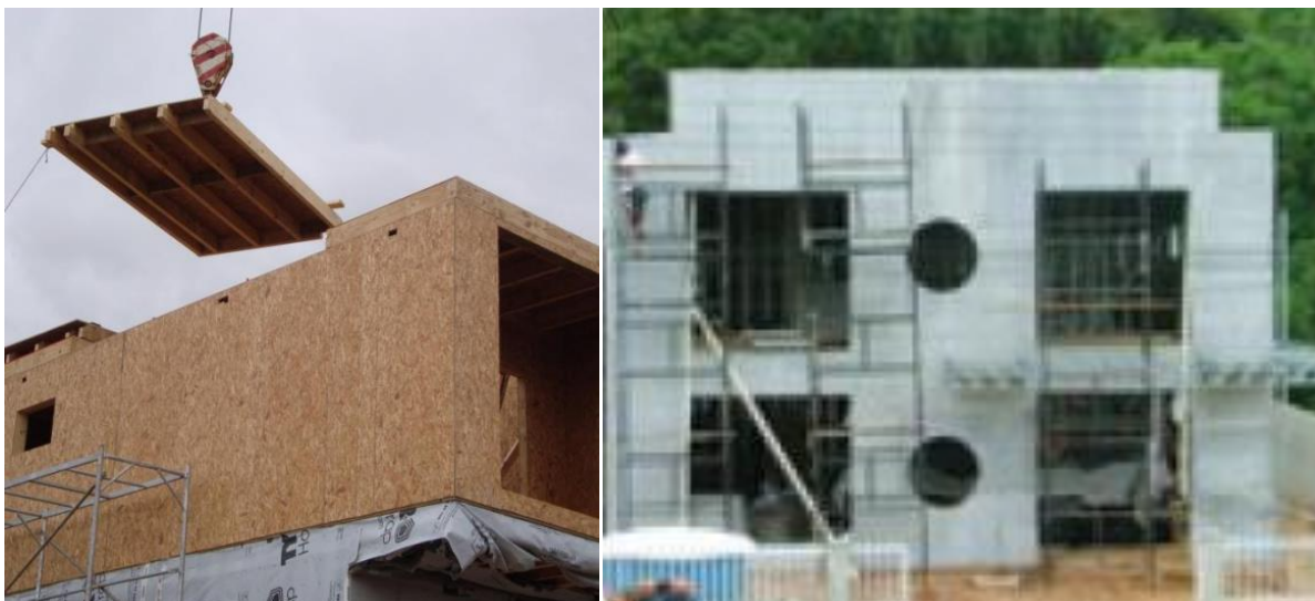
Figura 11: Fechamento Com OSB E Placa Cimenticia Respectivamente Fonte: Lp Buinding Products (2011).
