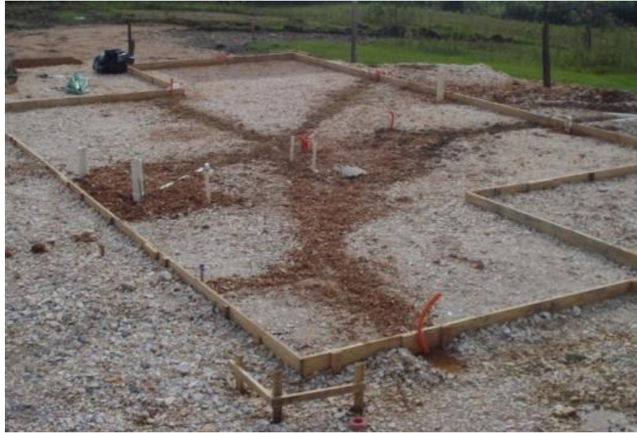
Figura 2: Forma De Radier Fonte: Edifique (2013).
