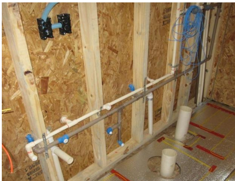
Figura 9: Instalação Hidros sanitária Fonte: Tecverde (2012).
